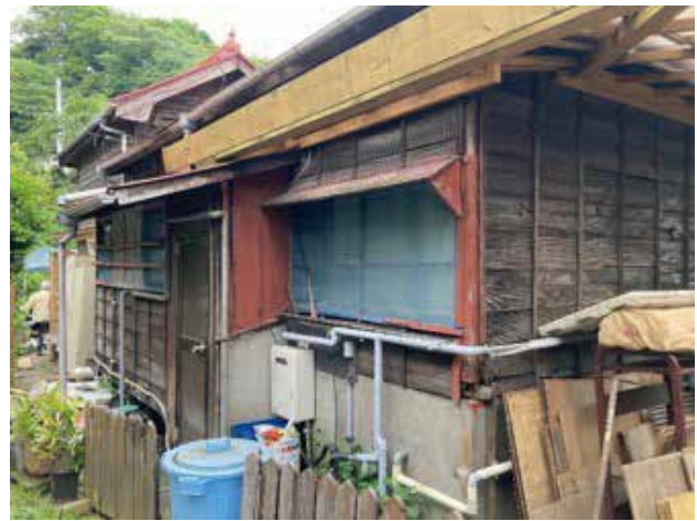
元浴室の窓からキッチンへの外壁
