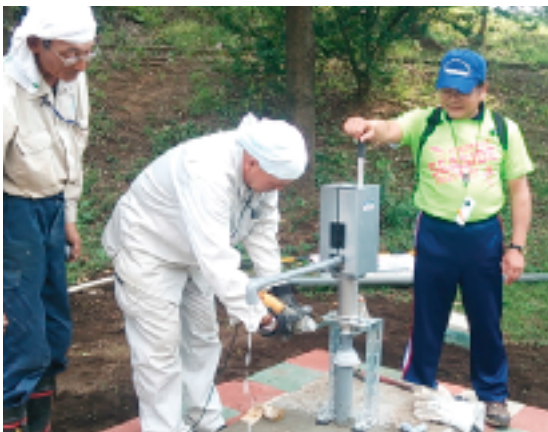
完成した防災井戸
