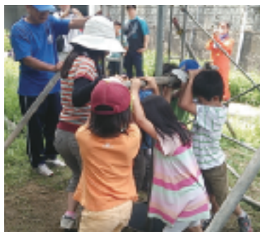
防災井戸の建設は単管を組んだ掘削装置で全て人力で掘り進めた
