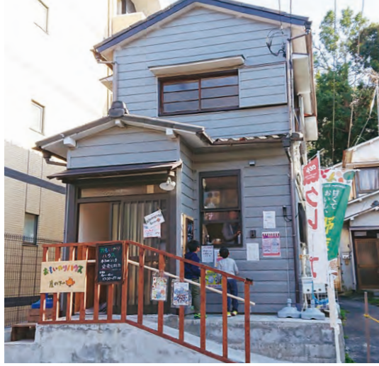
一見普通の住宅に見えるが、手すりの看板やクレープ販売のカウンターが内と外の距離感を縮めている
