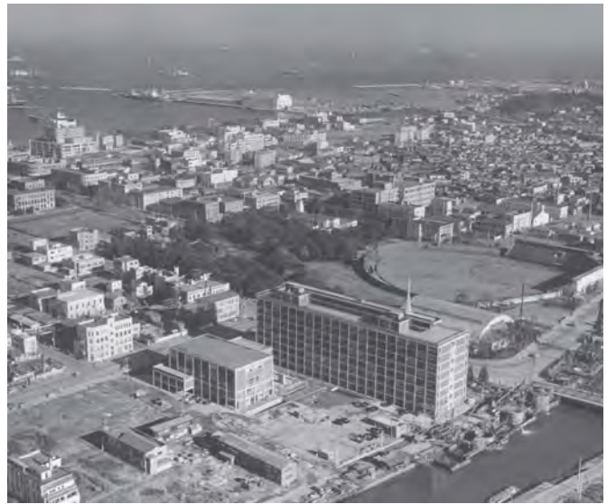
▲昭和34年竣工時
