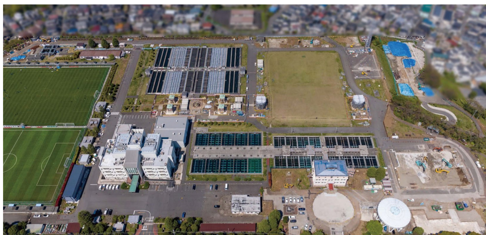
西谷浄水場(再整備事業前)
