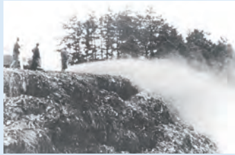
埋立場での消毒作業 Disinfection at a landfill site
