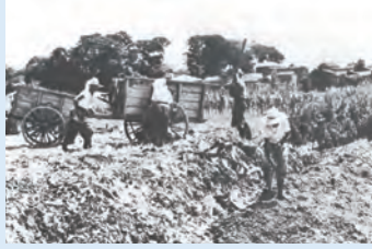
埋立の様子 Sight of a landfill
