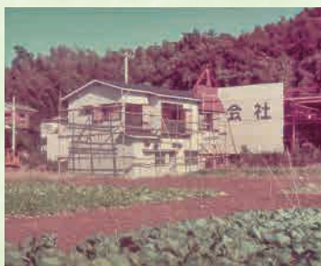
鴨居に建設中のおくだ動物病院
