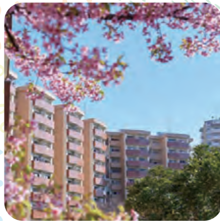
南永田団地は約2,500戸からなる大団地です。
