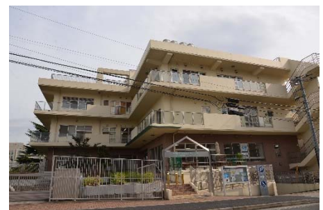
「みはらしポンテ」の外観
