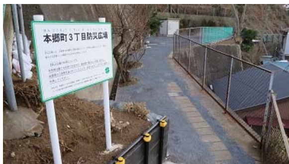
老朽空家の除去後に整備された「本郷町3丁目防災広場」
