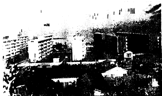
建設直後の小港団地
