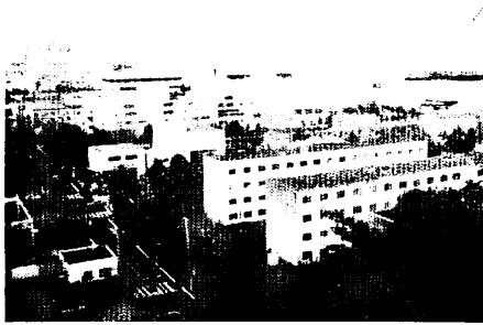
山手の丘から米軍鉄筋建物を見る（右手前4階建棟 左手は新山2下丁目の街並み）
