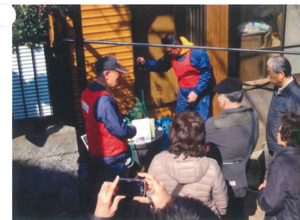
1号井戸ポンプ
