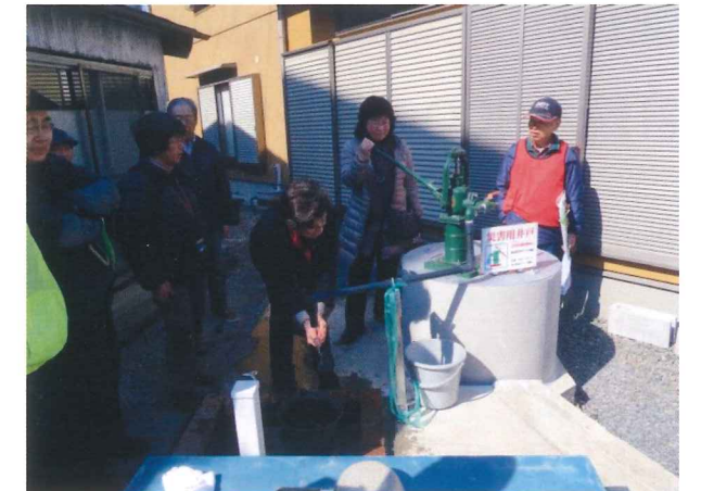
3号井戸ポンプ
