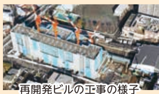
再開発ビルの工事の様子 (令和3年1月撮影)
