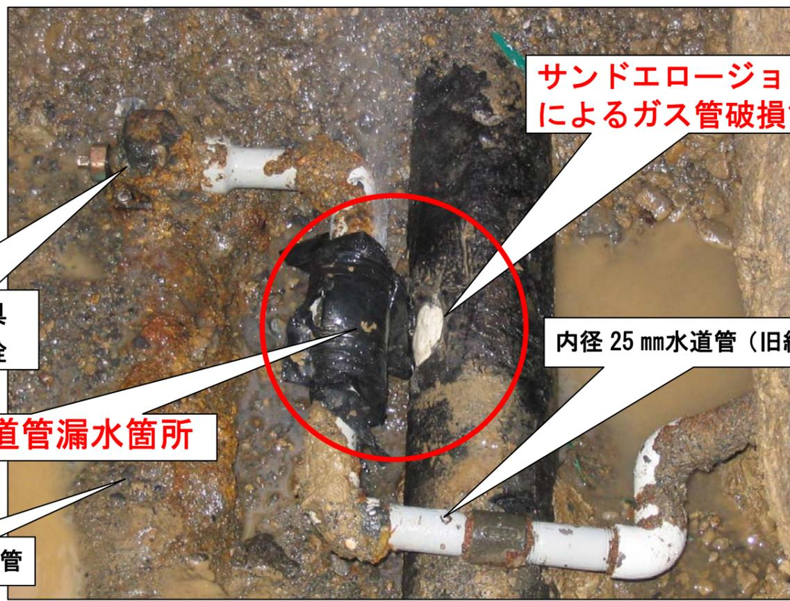
サンドエロージョン現象によるガス管の破損状況
