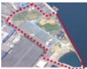
基幹的広域防災拠点（川崎港東扇島東公園）
