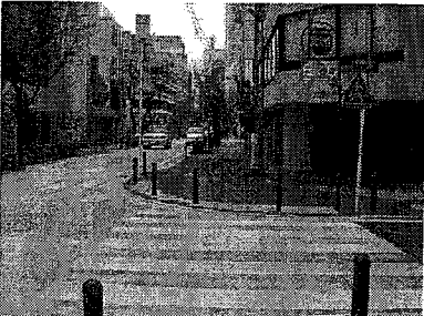
整備後（平成18年）
