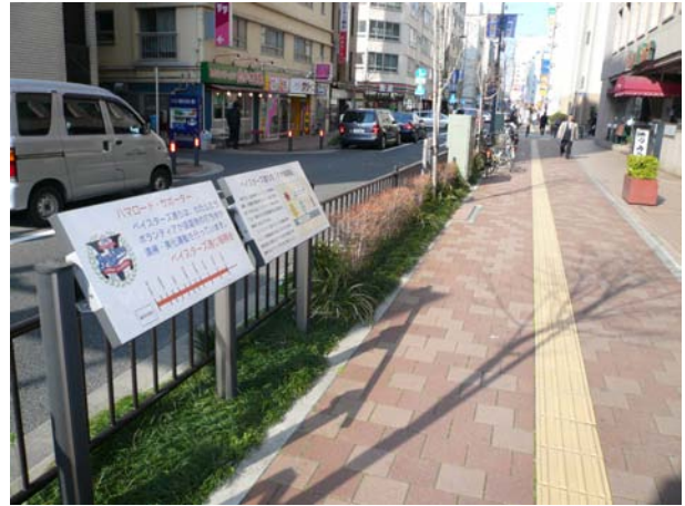
保水性舗装（ベイスターズ通り）
