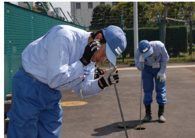
音聴棒による漏水音の捕捉技術の修得
