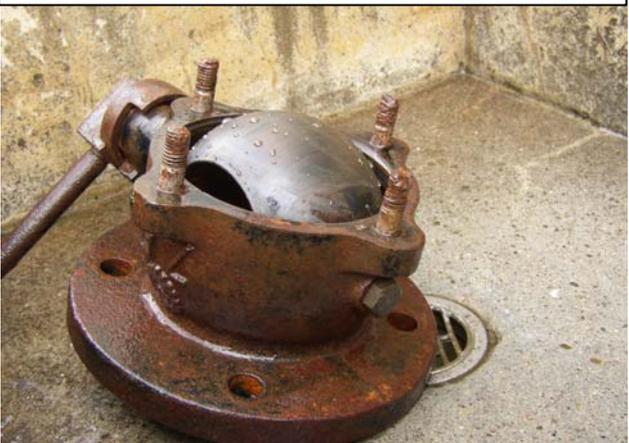
消火栓(補修弁)設置状況図
