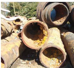
鋳鉄管(CIP) ※赤水や漏水の発生原因
