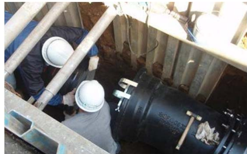
耐震管への布設替え工事
