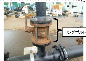
ロングボルトによる接続部の補強 （職員提案を採用）
