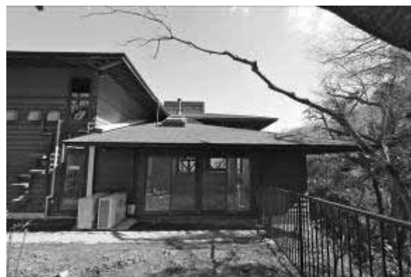
【写真】自然観察センター増築箇所
