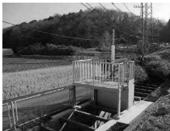
【写真】水田用水路の堰改修 (戸塚区、熊の堂水利組合)
