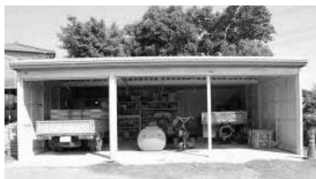
【写真】農業機械格納庫(泉区)
