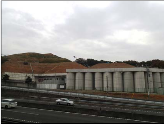
擁壁の設置状況
