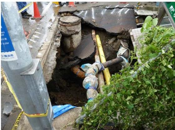
陥没した歩道及び埋設物露出状況
