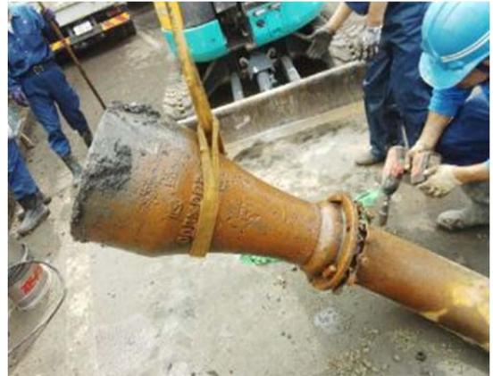
離脱した直径40センチ×20センチの管
