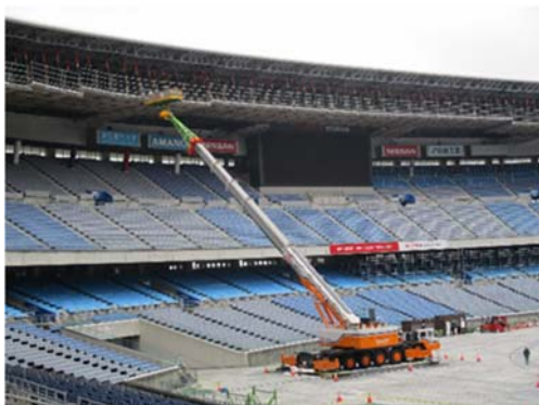
(横浜国際総合競技場の工事の状況)
