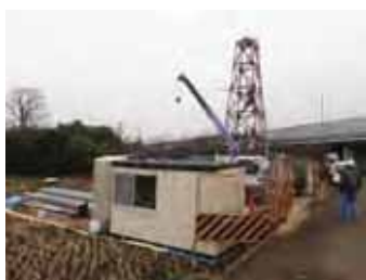
【写真】井戸掘削の様子（緑区）
