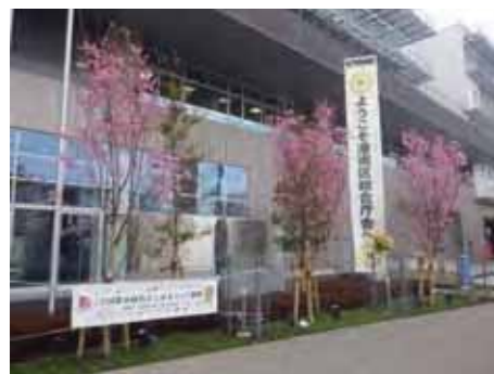
【写真】創出・事例（港南区庁舎）
