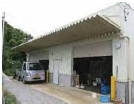
【写真】指定された農業用施設（栄区）
