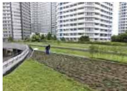
【写真】屋上緑化の事例 (西区みなとみらい)
