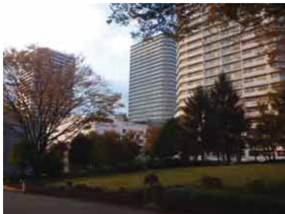
【写真】保全契約の事例（集合住宅） （戸塚区品濃町）
