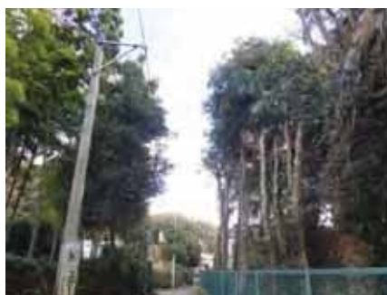
【写真】 作業前（上）と作業後（下）（戸塚区）
