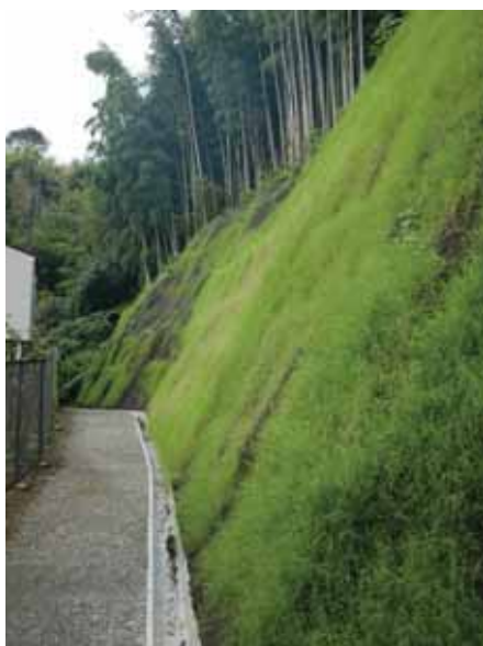
【写真】法面の整備
