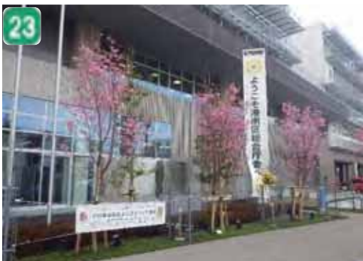
23 公共施設・公有地での緑の創出・管理 (港南区庁舎)
