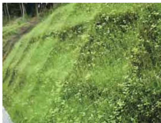
【写真】法面の整備
