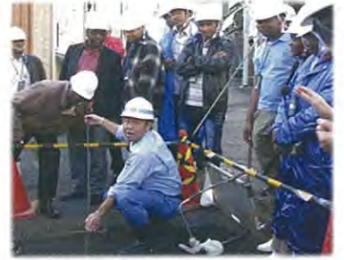
アフリカからの研修生受入れ (漏水修繕工事の様子)
