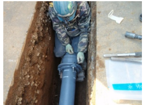
耐震管への更新工事
