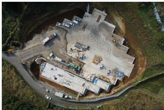
雨水調整池の築造工事中（ドローンにて撮影）
