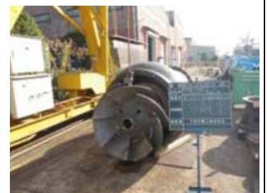
ポンプの主要部品の交換
