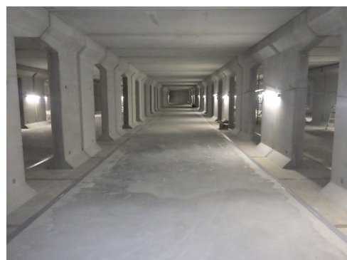
雨水調整池の内部
