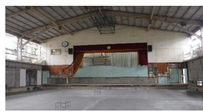
小学校体育館の改修工事
