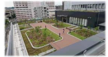
屋上緑化（南区役所）
