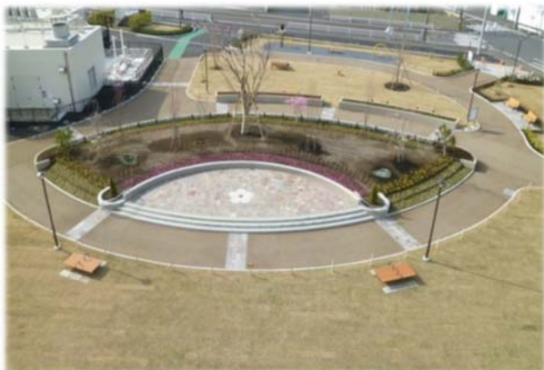
星川中央公園（雨水調整池の上部利用）
