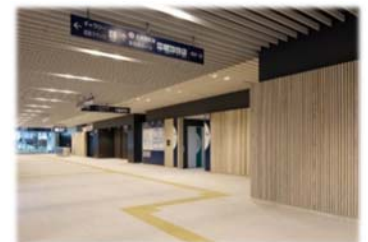
公共建築物の木質化整備工事 （南区総合庁舎）
