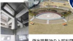
雨水調整池の上部利用（星川中央公園）
