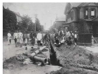
山手で行われた配水管工事の様子（明治30年頃）
