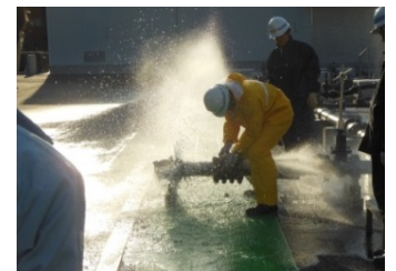
管路研修施設 配水管修理デモ
