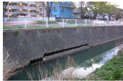
老朽化による護岸崩落（平戸永谷川）
