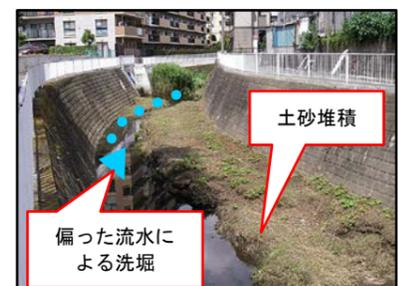
土砂堆積の影響による洗堀の例
