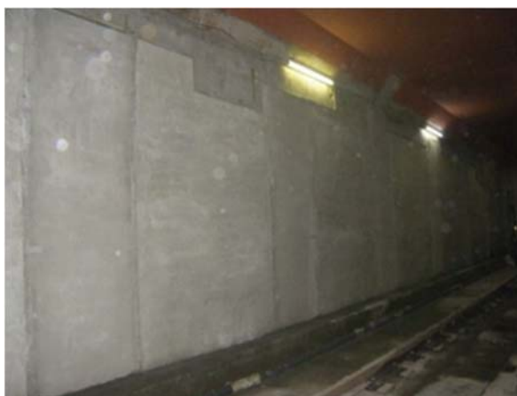
<関内駅構築補修>
