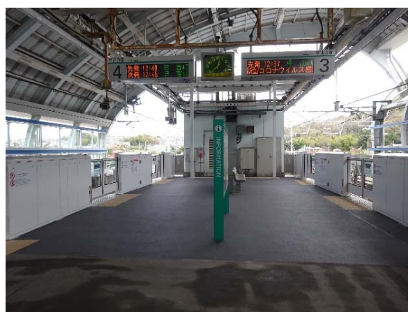
<駅ホーム延長部>
