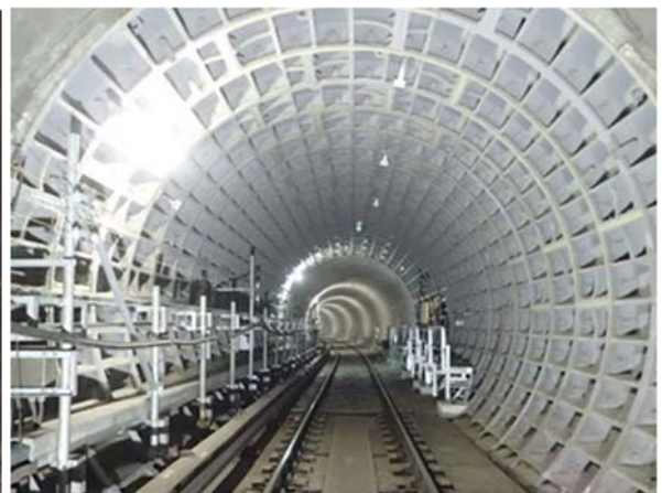
<シールドトンネルの補修>
