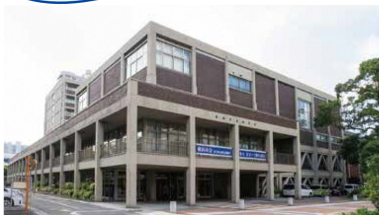
横浜市会議事堂の外観 昭和34(1959)年に横浜開港100年を記念して建てられました。
