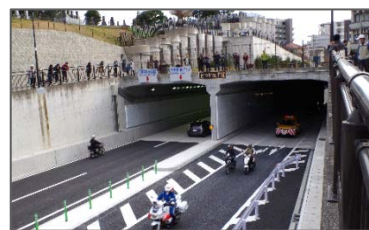
柏尾戸塚線（とつか地下道）
