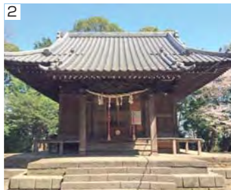
山田神社 (南山田町) その草創は明らかではないが、『新編武蔵風土記稿』にある棟札の記事から、少なくとも室町時代末期まで遡ることができます。現在の本殿は天保13年(1842)に造営されたもので、その凝った造りや彫刻と建物との調和が素晴らしい、市の文化財に指定されています。
