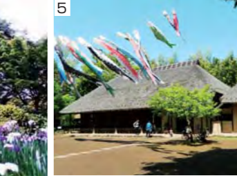
5 旧長沢家住宅主家と馬屋 (都筑民家園) (大棚西) 大塚・歳勝土遺跡公園内にある、牛久保村にあった古民家を移築・復元しました。奇棟造の茅葺きで、間取りや柱の構造的特徴から18世紀中頃からそれ以前の建築と推定されます。市指定文化財。
