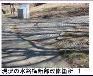
現況の水路横断面改修箇所-1
