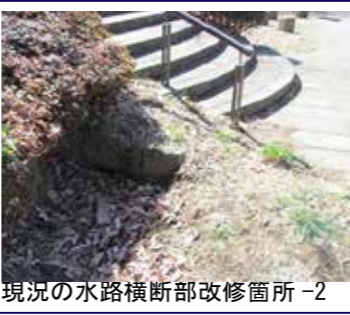
現況の水路横断面改修箇所-2
