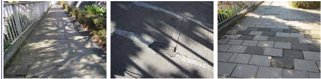
現況の白河石板石舗装 現況の白河石板石舗装の目地の痛み 現況の赤御影石舗装のアスファルト補修
