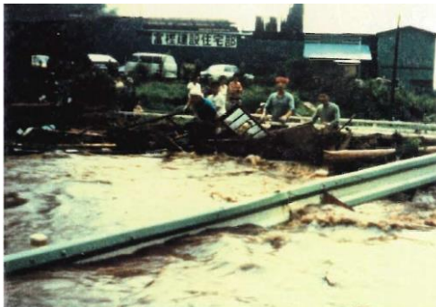
昭和51年9月8日 台風による浸水 （早淵川・布川合流点上流）
