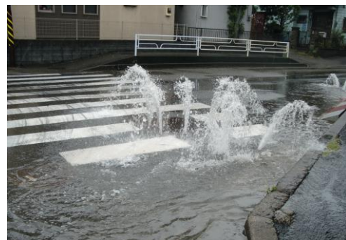
平成25年8月21日 台風による道路冠水 （川和町）
