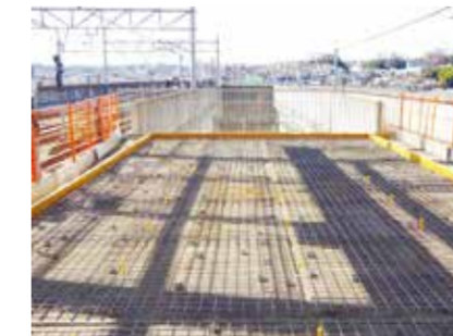
駅ホーム工事(川和町)
