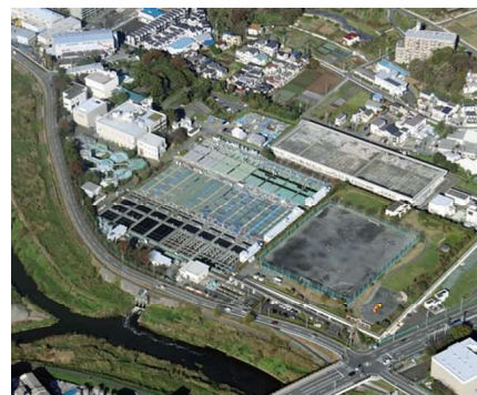
都筑水再生センター
